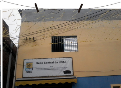
Figura 15: Entrada da Sede UNAS
